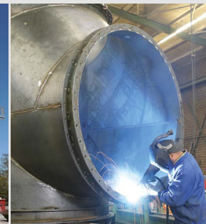
Plant assembly at Hellmich Anlagenbau im Hause Hellmich
